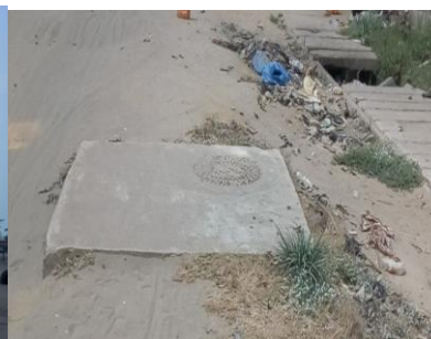
Photo 5: Ouvrage de la SONEB
