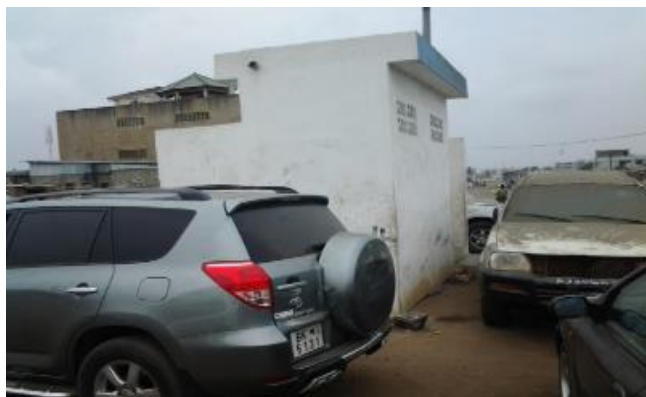
Source : travaux de terrain, 2018
