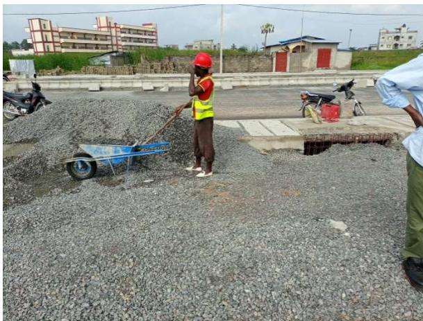
Rue 1 du projet Asphaltage en cours d'exécution. Début SMP 12
