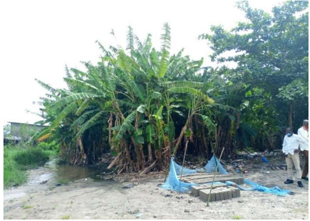
Exutoire du collecteur SMP 12
