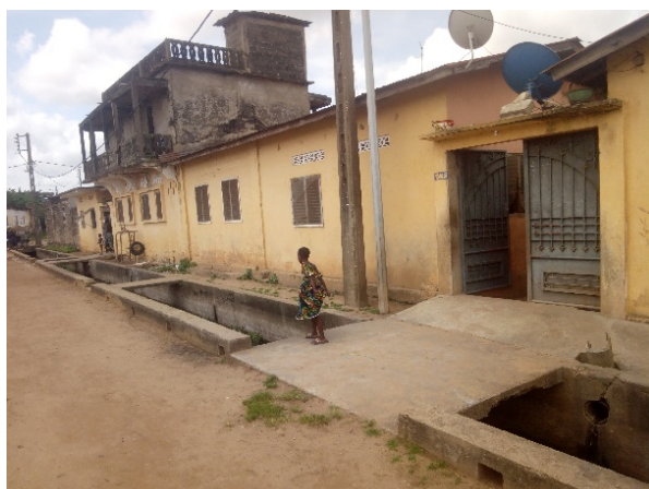
Habitations évacuant directement les eaux usées dans le collecteur EP11
