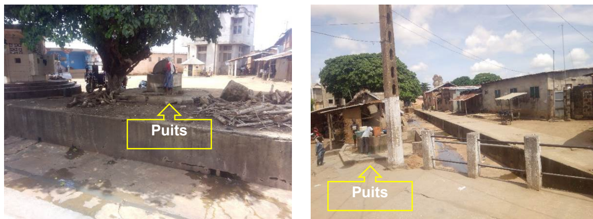
Planche 2 : Puits forés à proximité du collecteur EP11
