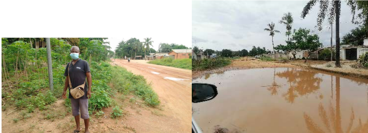
Planche 21 : Etat de l'assainissement actuel de la voirie structurante VS-Oui 08
