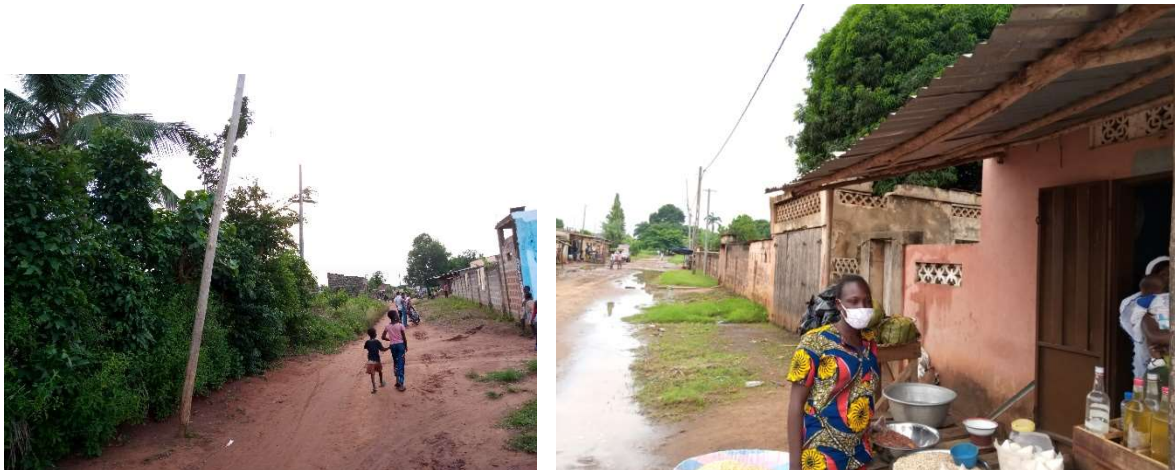
Planche 18 : Etat de l'assainissement actuel de la voirie structurante VS-Oui 05
