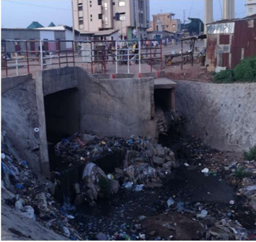
Lit et ouvrage sur un collecteur existant encombré de déchets et de sable Parakou, juin 2020
