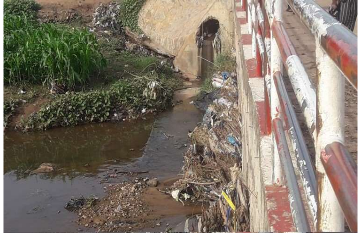
Lit et ouvrage sur un collecteur existant encombré de déchets et de sable Parakou, juin 2020
