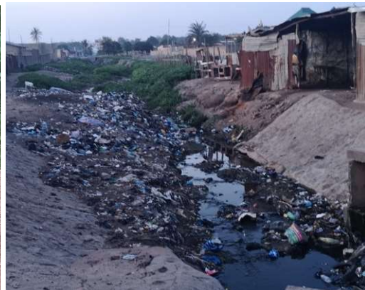
Planche 5 : Accumulation de déchets solides dans les collecteurs et les ouvrages de franchissements – obstacle pour le drainage des eaux
