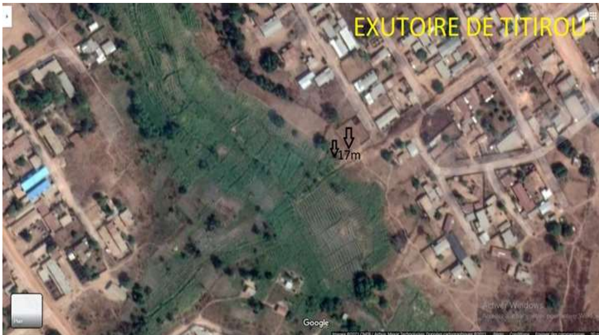
Planche 16 : Vue aérienne de l'exutoire des collecteurs du bassin A4 (position 9°18'35.77" N ; 2°40'10.03" E)
