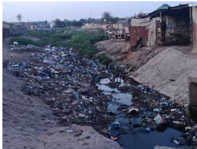
Planche 22 : Collecteurs et exutoires encombrés de déchets
