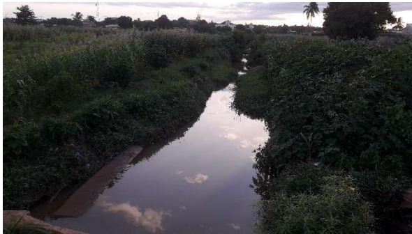
Planche 4 : Voie de drainage des eaux pluviales non aménagées qui débordent parfois vers les habitations et les rues
