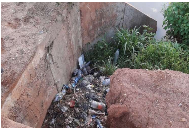
Planche 5 : Accumulation de déchets solides dans les collecteurs et les ouvrages de franchissements – obstacle pour le drainage des eaux
